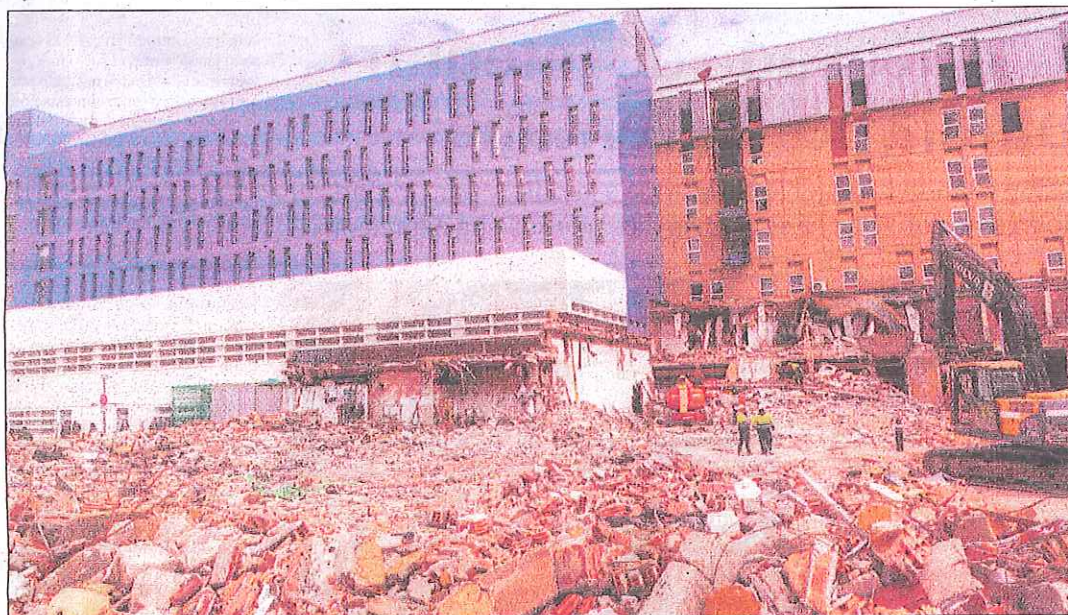
La demolición del antiguo edificio de rehabilitación prepara ya la unión de los edificios principales. MARIO TEJEDOR
